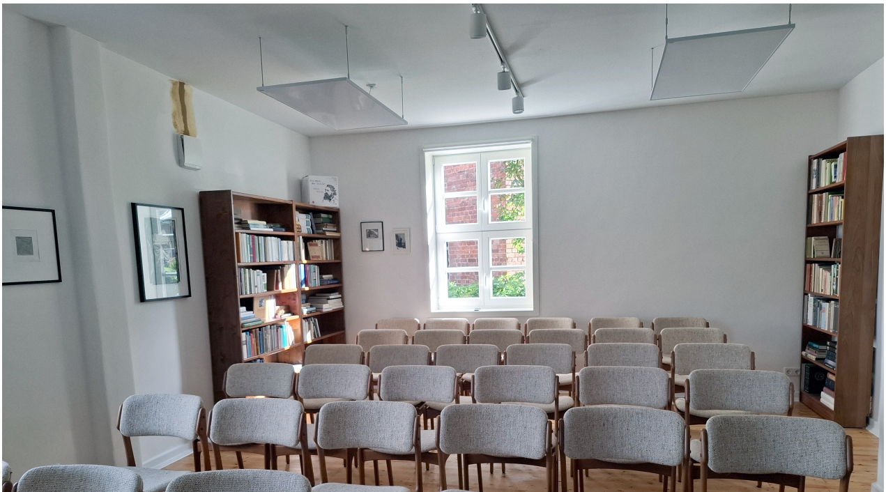
Der frisch renovierte Veranstaltungsraum im Hille-Haus. Unter der Decke sind die neuen Infrarot-Heizkörper und die Lichtleiste erkennbar.
